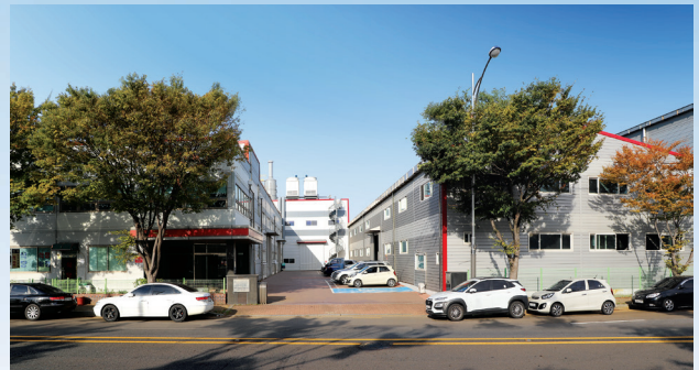
Toàn cảnh nhà máy số 2 第2工場全景
